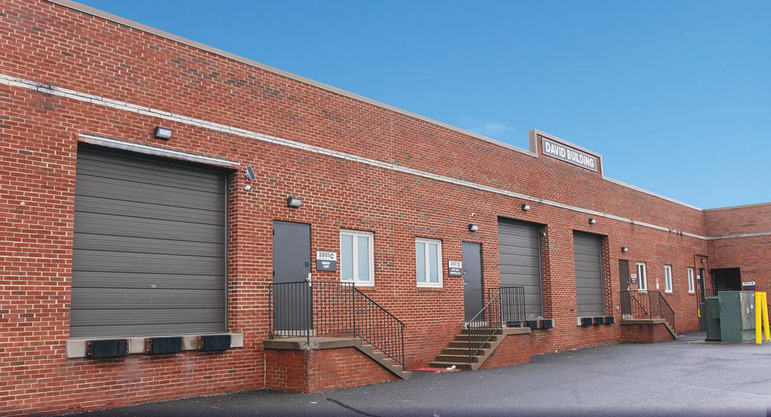
LOADING DOCK 2801C-G
